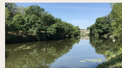
Le Pont de Corné
